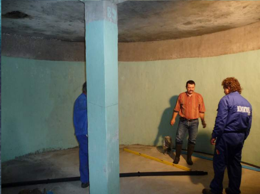
DE Behälterbegehung vor Auskleidung // CZ Kontrola nádrže před montáží
