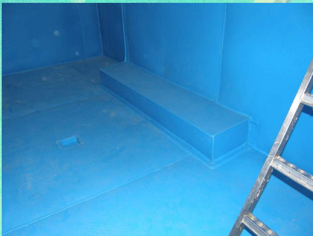
DE Detailansicht Beckenboden mit Stufe // CZ Detail dna nádrže se schodem
