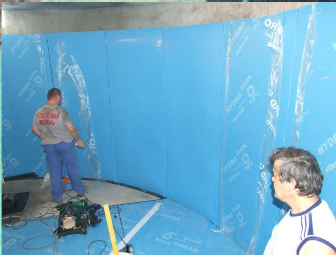
DE Bodenverlegung // CZ Pokládka podlahy
