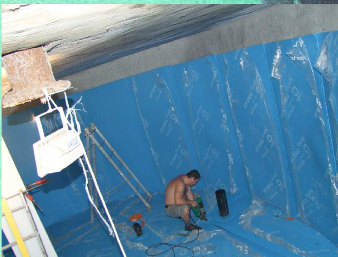
DE Detailansicht Rohrdurchführungsmontage // CZ Ukončovací práce
