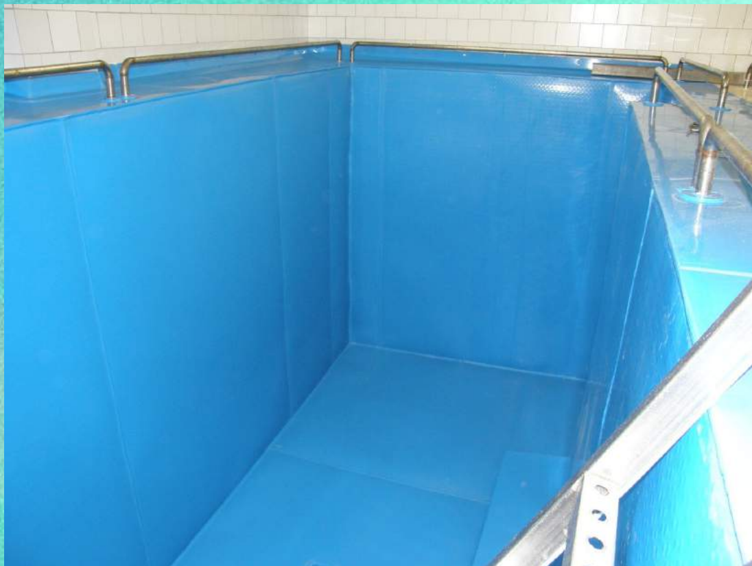
DE Fertig verlegter Hydro Click Behälter // CZ Dokončení montáže Hydroclicku v nádrži
