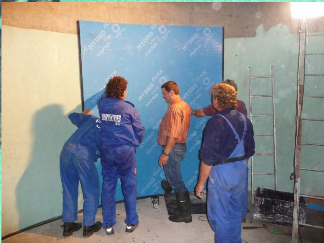
DE Installation des Hydro Click Systems // CZ Instalace systému HYDROCLICK
