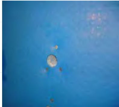
Lochbohrung mit anschließendem Reinigung durch Hochdruck
