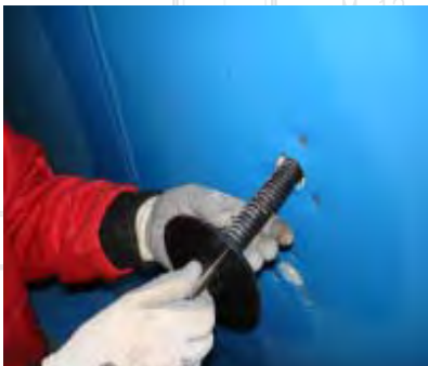
Eindreihen des BA-Ankers vor dem Aushärten des Klebers
