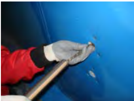
Füllung mit Sikadur 31
