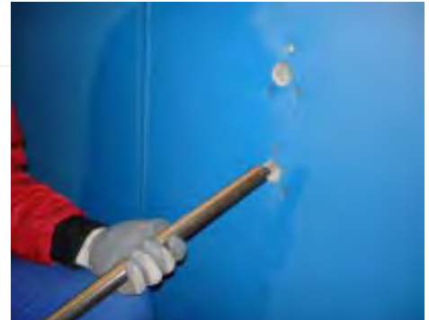
Epoxid-Kartusche wird angesetzt
