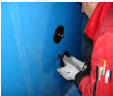
Einsetzen des zweiten Ankers
