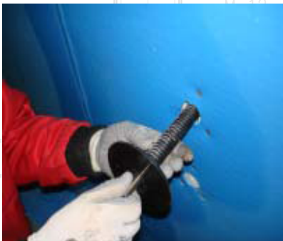
Zatočení BA kotvy před vytvrdnutím lepidla
