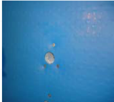
Vrtaný otvor s následným vyčištěním vysokým tlakem
