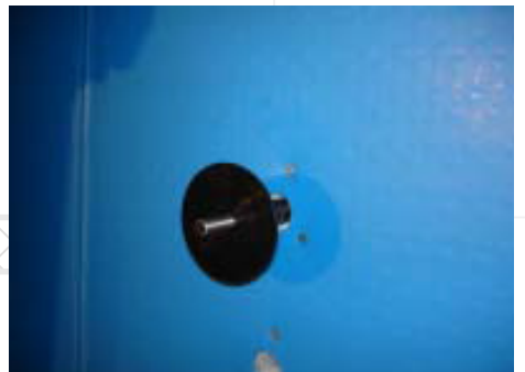
Odstranění zbytků lepidla před konečným ukotvením
