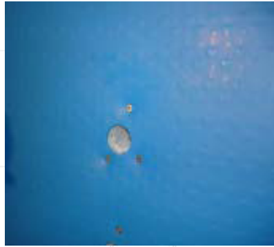
Пробит отвор, подготвен за пълнене с монтажно лепило
