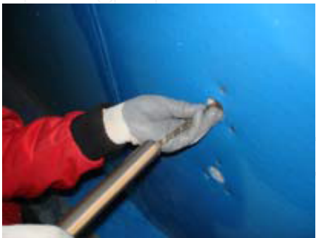
Запълване със Sikadur 31
