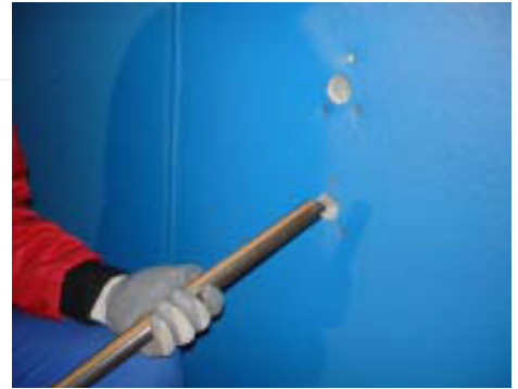
Запълване на отвора
